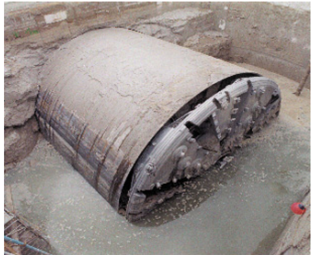
Tunnelbohrmaschine im Zielschacht
