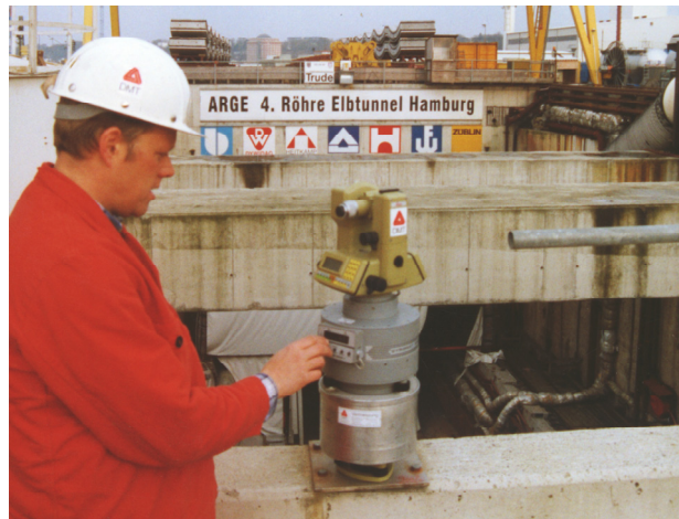
Kontrollmessungen am Elbtunnel
