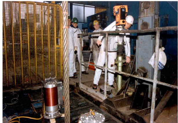
Einrichten der Messgeräte zur Schachtvermessung
