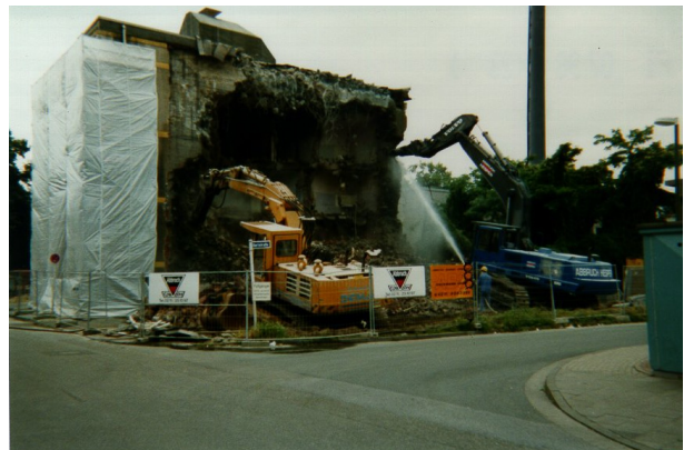
Abrissarbeiten an den Hochbunkern
