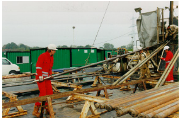
Vorbereitung des Coal-Combi-Shuttels
