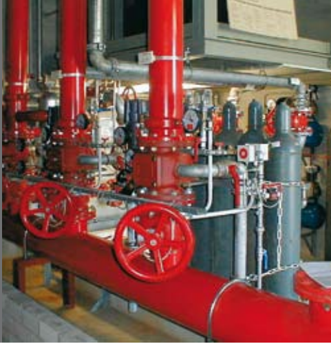
Bild links: Sprinklerzentrale
