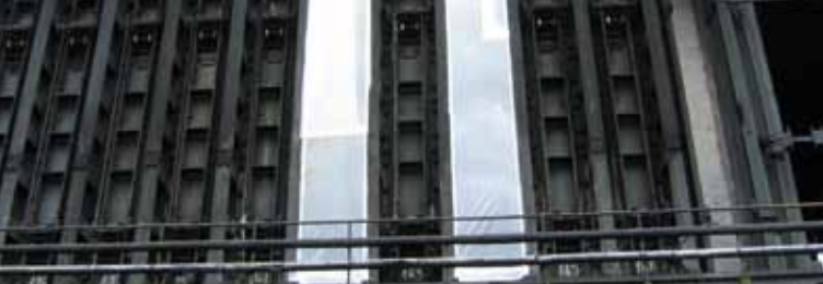
Замер выбросов на дверях коксовальной печи
