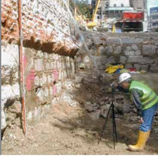
Bild links: Geotechnische Untersuchungen beim U-Bahn-Bau
