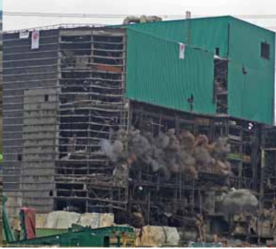
Bild rechts: Rückbau Bergwerk Walsum
