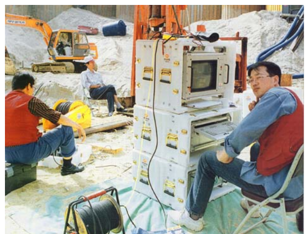
Gründungsfundament f. Brückenpfeiler, Seoul (KR)
