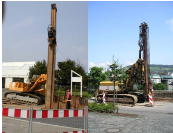
Spundarbeiten in einem Industriegebiet
