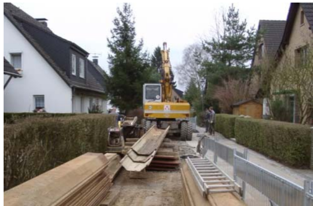
Kanalbaumaßnahme in einem Wohngebiet
