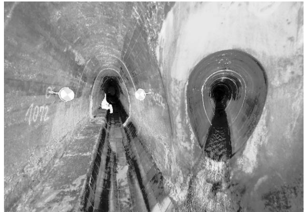
Laserscan (Punktwolke) eines Abwasserkanals
